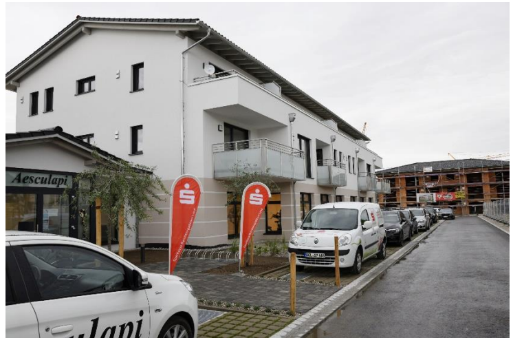
Der erste Bauabschnitt mit 16 Mietwohnungen und einer Gewerbeeinheit für die Physiotherapiepraxis ist übergeben, im Hintergrund wird fleißig an den 39 Eigentumswohnungen gebaut.
